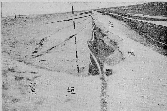
写真17 翼垣設置と砂丘形 鶴岡營林署管内濱泉國有林に於て写真(21)堆砂後設置 せる翼垣により風の攪亂を誘致し主垣に風裂を生ず (昭和九年撮影)
