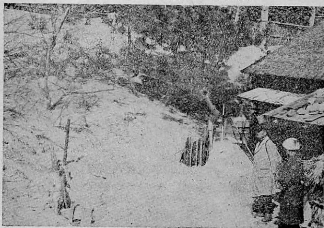
寫眞10 境界標柱の飛砂に埋没の狀況 鶴岡營林署管内八間山國有林 119 號標柱建設大正八年、埋没の爲め引揚、昭和三年十二月、揚引前の埋没深度44cm前年よりの堆砂量15cm (昭和四年三月撮影)
