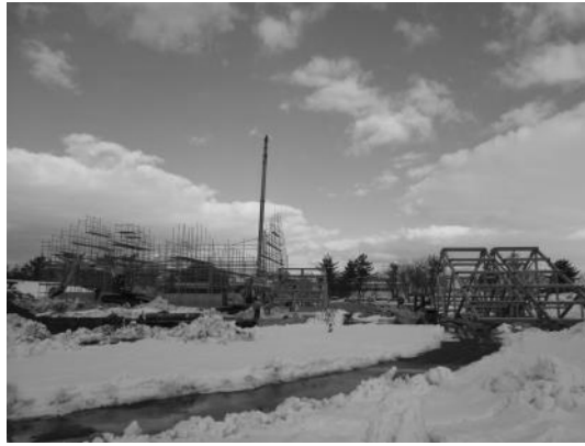
図ー1 建設中の木質バイオマス発電所
