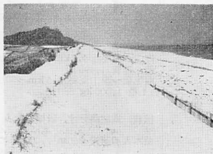
写真1 前砂丘築設の状況
