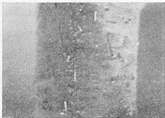
被害外部（たれ下った虫糞がみえる）
