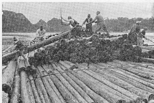
第IV図 編筏作業のうち丸太積付
