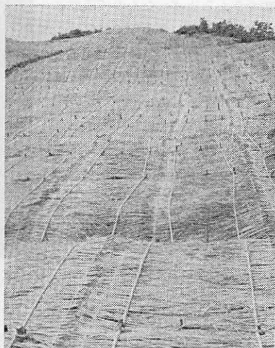
写真-3 ムシロ張工（山腹緑化工） 北海道尻岸内村（1961）
