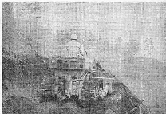
写真2 階段工施工中のアングルドーザ
