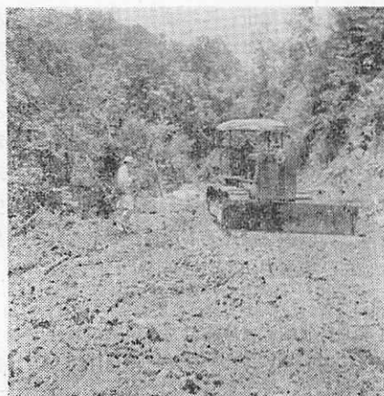
ブルドーザによる林道開設作業
