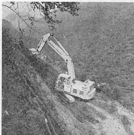
急斜地における理想的な林道掘削作業
