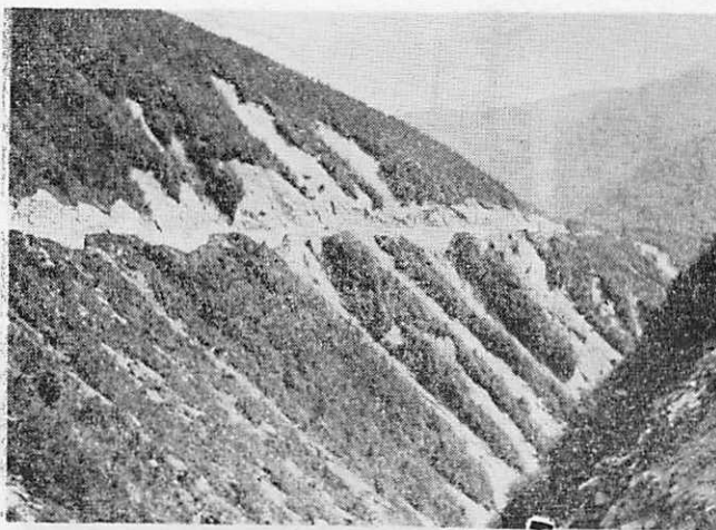
写真—5 道路建設に伴う崩壊と捨土
