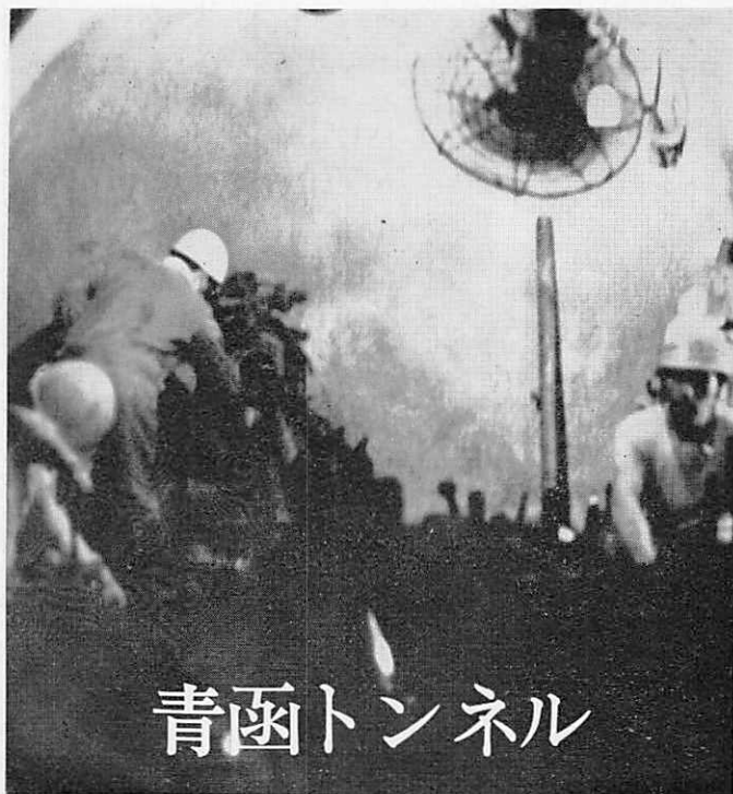
坑道の前進を探る先進ボーリング
