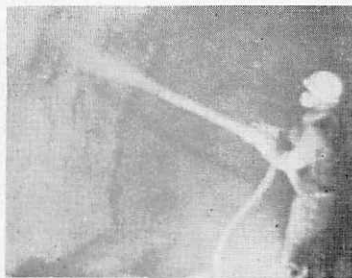
コンクリートの吹付（坑道 掘さく直後の坑壁保持）
