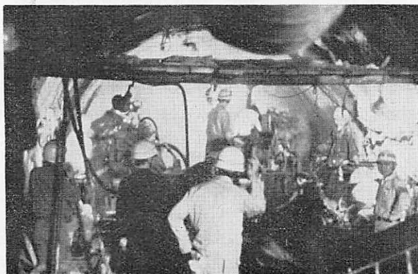
地質不良箇所改良のための注入
