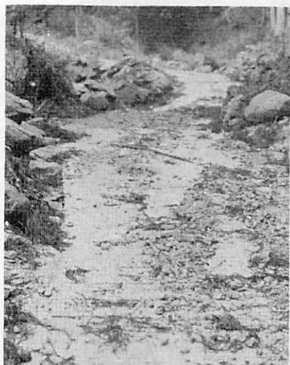
写・3 渓流の近くを通る林道の出水を配慮した路体
