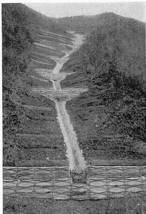
鋼棒ソイルセメント土留工法により崩壊地復旧
