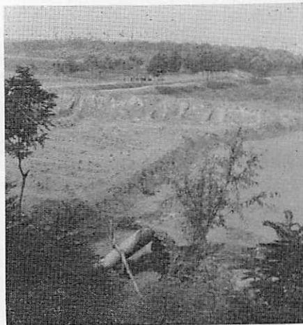
写真・1 堤防幅を100 mにする工事。ポンプ船で吸い上げた土砂を吐いている。
