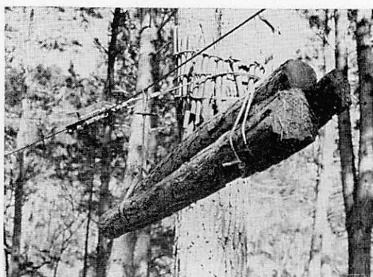
写真・4 架空索集材（小林専門家原図）
