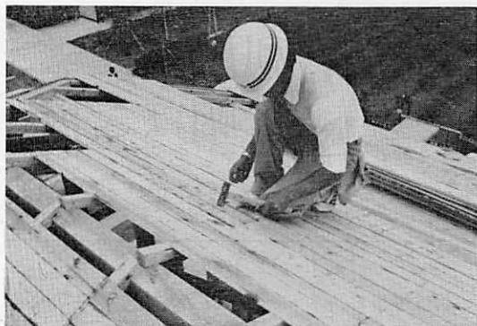
写真・1 幅はぎ板の施工
