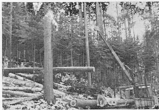
写真・3 トラッククレーン（レンジャー 4 D ユニッククレーン）集材
