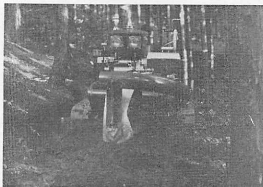
写真・2 小型機械による簡易作業道の開設
