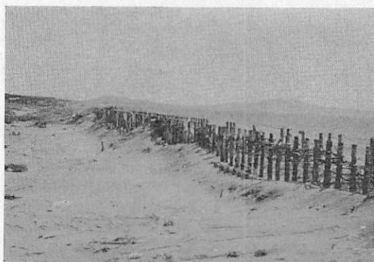
写真・3 波浪による前砂丘の侵食欠壊 (秋田県能代市砂山地区)
