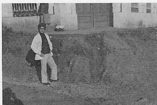
写真・4 流水により浸食を受けた道路
