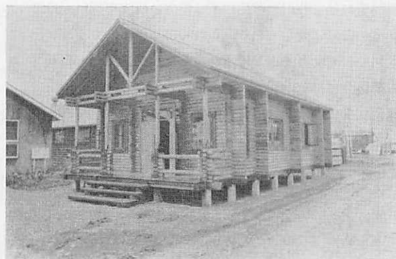
ログハウス 直径 14 cm の円柱材 500 本（長さ 3.65 m 換算）を積み重ね、床面積 82 m 2 （約 24.5 坪）の建物をつ造った。
