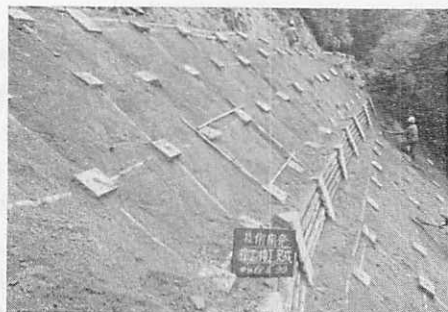
山腹新工法全景 (のり棒工・土留工)
