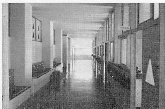
写真・3 床・間仕切りに木材を使用している（小学校） 冷たいためにカーペット敷に改装しようとしている。
