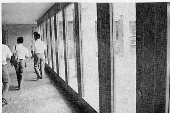
写真・3 屋外に面した窓も木製サッシ(ベイツ)。廊下は広葉樹集成フローリング
