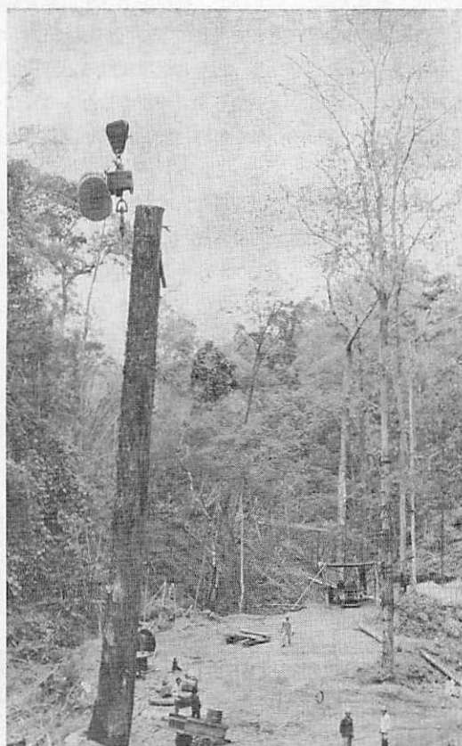
象から機械に——タイにおける第1号集材線
