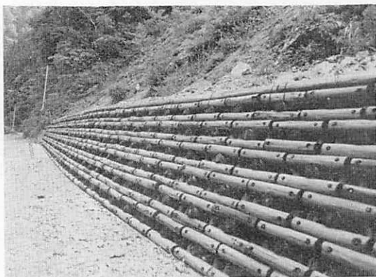
ウッドブロックの施工状況
