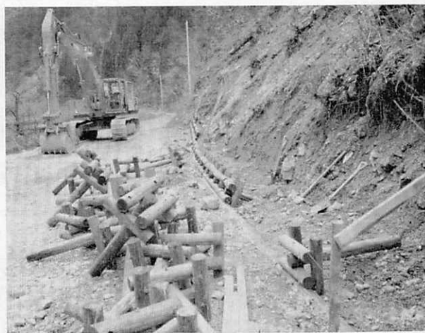
土留用として施工中のウッドブロック
