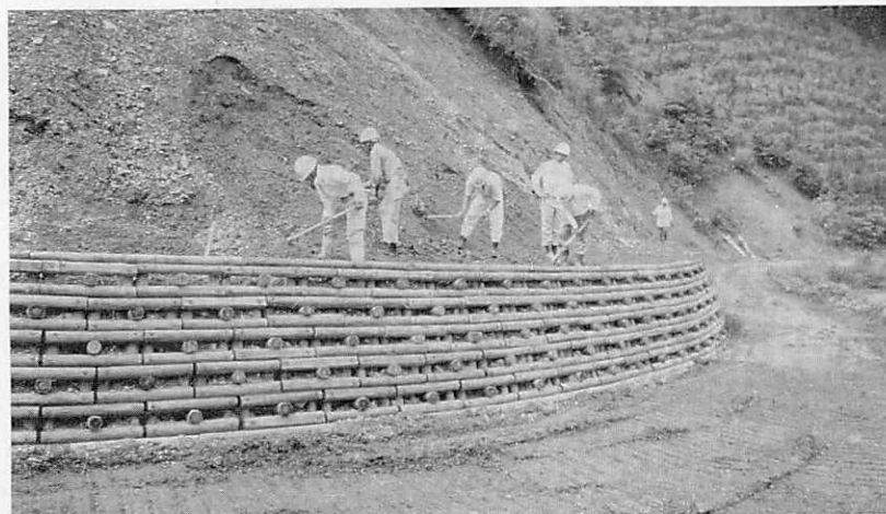
山側土留用として施工されたウッドブロック（熊本管林局鉄肥管林署管内）
