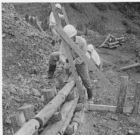
土留用として施工中のウッドブロック
