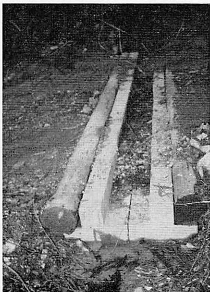
逆T字型のコンクリート構造物を組んで簡単に横断溝をつくっている
