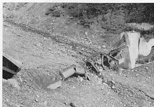
写真・4 鋼製バットレス・スクリーンダムの破壊例
