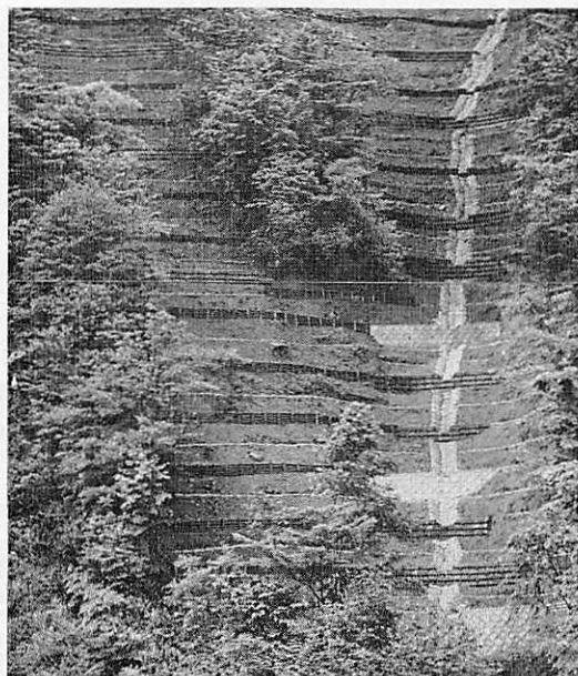
コンクリートブロック、ウッドブロック、編柵を組み合わせて施工した山腹工（熊本営林局矢部営林署管内）
