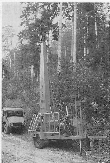
写真・3 簡易架線集材機 (ユーゴスラビア)
