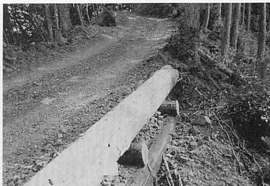
写真・4 その場排水と路肩補強をねらった路側構造
