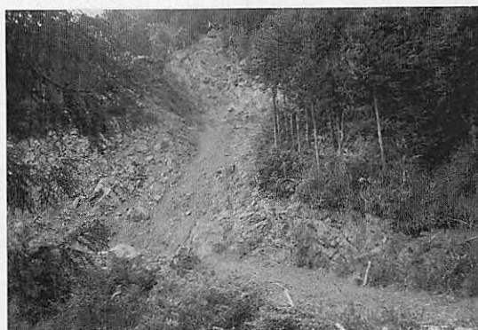
写真・1 道路より上の斜面の崩壊
