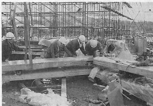
写真・4 ドリフトピン接合作業
