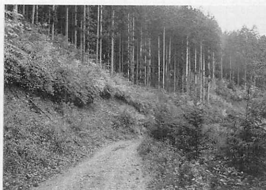
写真・2 構造物等が省略されている幅員3mの作業道 (静岡県天竜地域)
