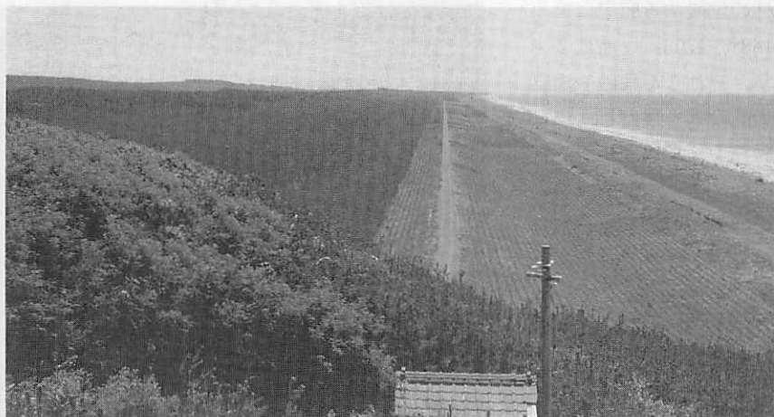
写真・2 庄内砂丘海岸林：人工砂丘を造成し、海岸砂地造林をしているところ（昭和47年撮影）
