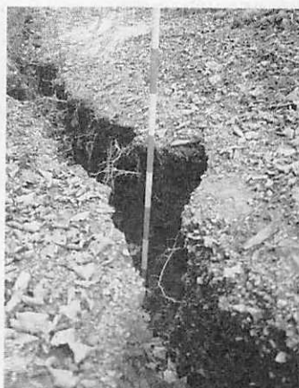
写真・1 無施行箇所の例 (作業終了後約3カ月半の期間にできた雨裂の状況)
