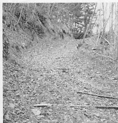
写真・2 施行箇所の例 (作業終了後約3カ月目の枝条伏設状況。枝条伏設時より流水跡に顕著な変化はない)
