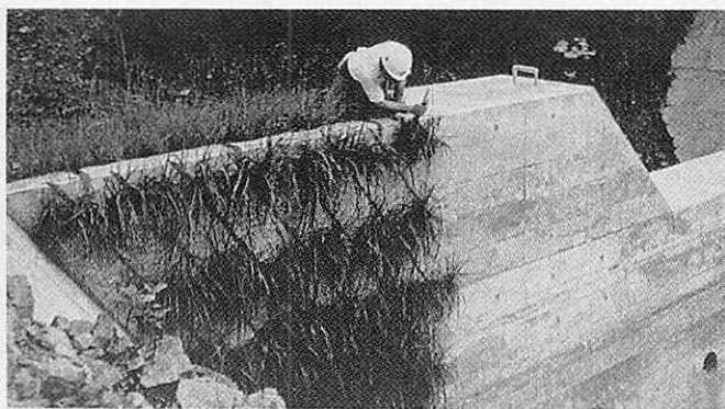
写真・3 堰堤の壁面緑化
