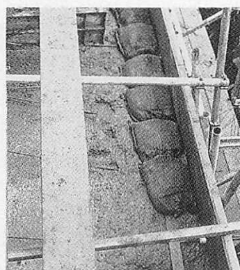
写真・4 植生土のう設置状況
