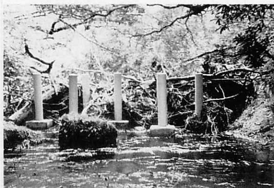
写真・1 鋼製杭打工法
