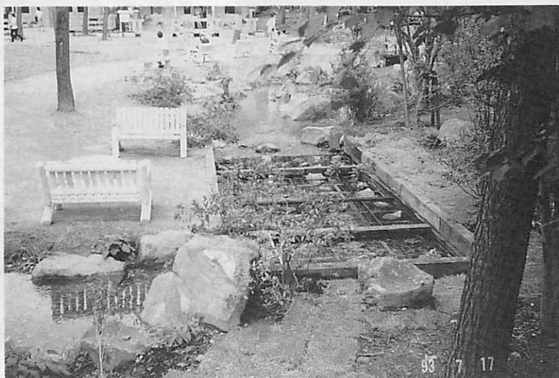
写真・1 信州博覧会で設置した木炭による浄化施設
