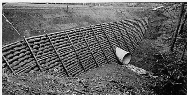
写真・木枠緑化土のう積（S 59 年完成）
