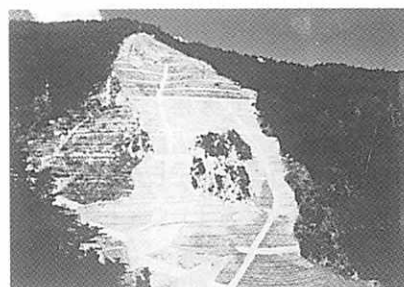
同地区の谷止工、護岸工、山腹施工状況
