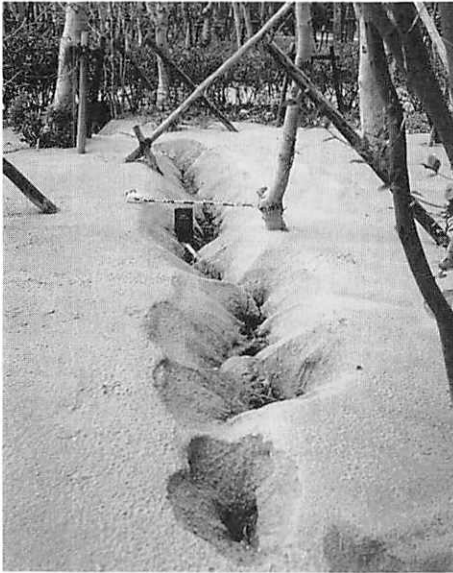
写真・1 ポートアイランド南公園の液状化現象
