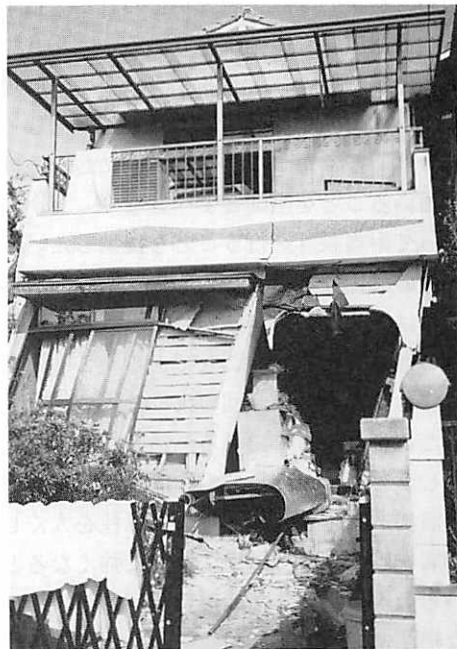
写真・2 狭小な土地に建てられた住宅は間口に十分な耐力壁を設けられなかったため大きな被害を受けた
