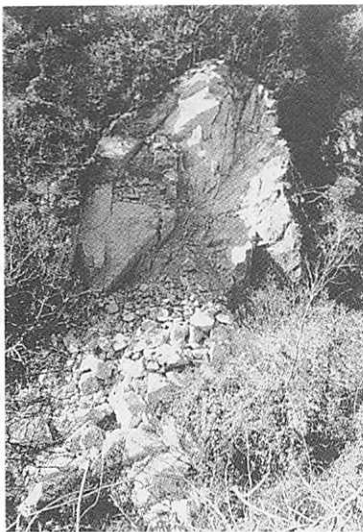
▲川に面した岩壁の崩落(芦屋川中流部)
