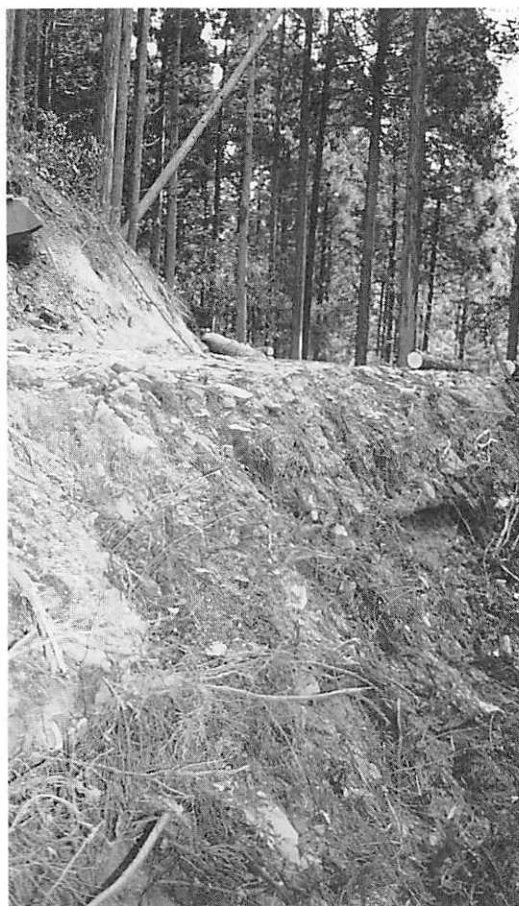
写真・1 盛土は8分程度の法勾配でも安定している(埋められた伐根が手前側に見える)
