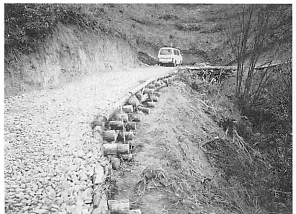
写真・1 作業道（丸太組工法）開設当時の状況 （島根県那賀郡金城町小国 笹杉奥作業道）
