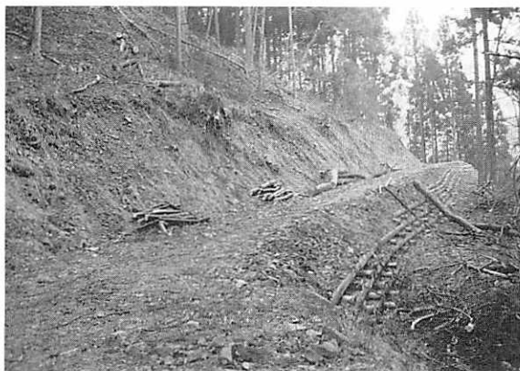
写真・3 間伐材による丸太組工の施行例 (林業経営作業道 幅員=3.0m) 下仁田森組
