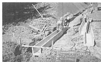
U型トラフ工の敷設状況
