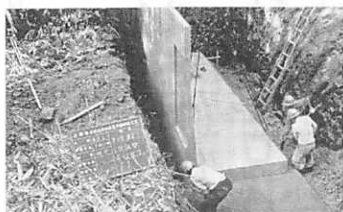
L型擁壁工の敷設状況
