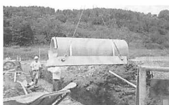
管渠工の敷設状況
