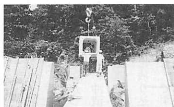
ボックスカルバート工の敷設状況
