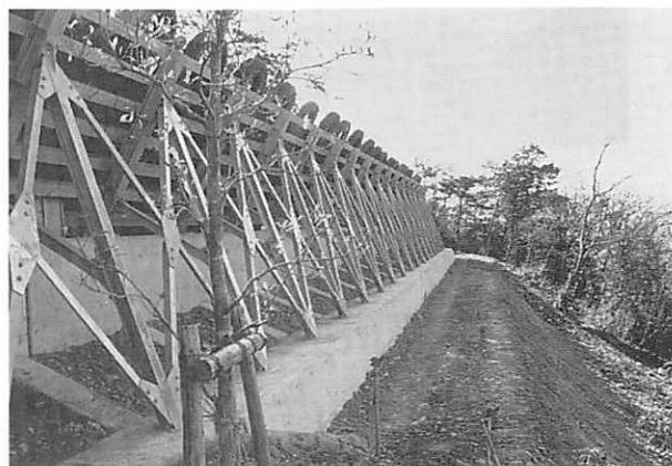
写真② 落石防護工
