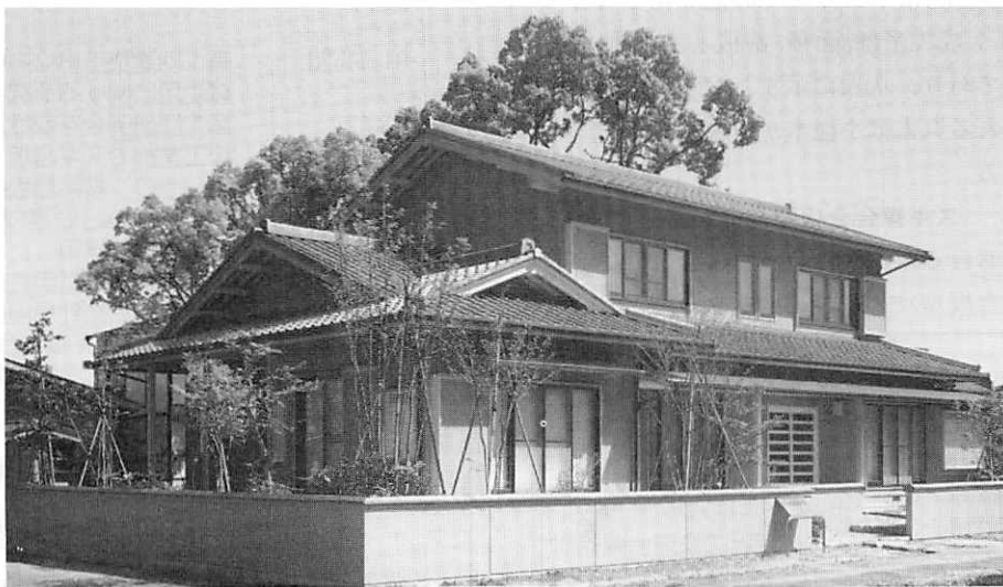
写真② 軸組+壁パネル工法による(協)ひだ萩原の家「ときめ木の住まい」 (木の住まい白鳥ハウジングセンター、名古屋)
