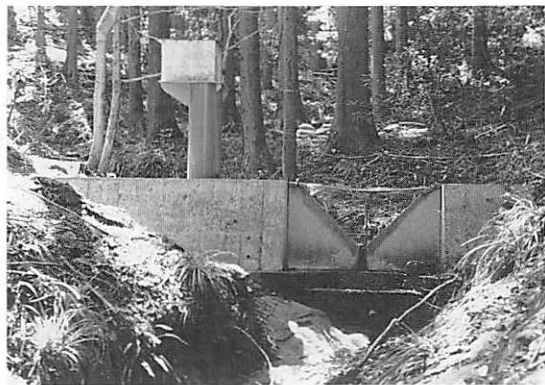
写真① 東京大学農学部附属千葉演習林袋山沢試験流域に設けられた量水堰堤。1998年に伐採が予定されている。
