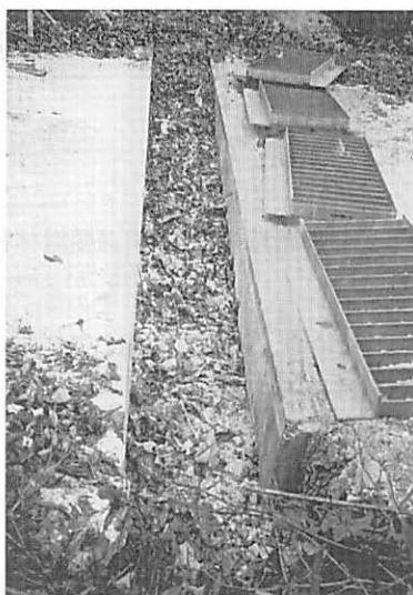
写真① 従来タイプの土砂堆積状況
