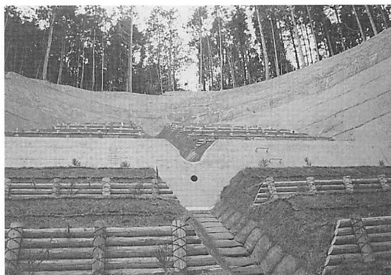
写真① 丸太木柵工
