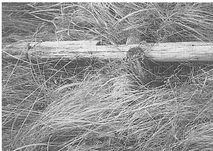
写真④ 丸太法粋工の腐朽状況
