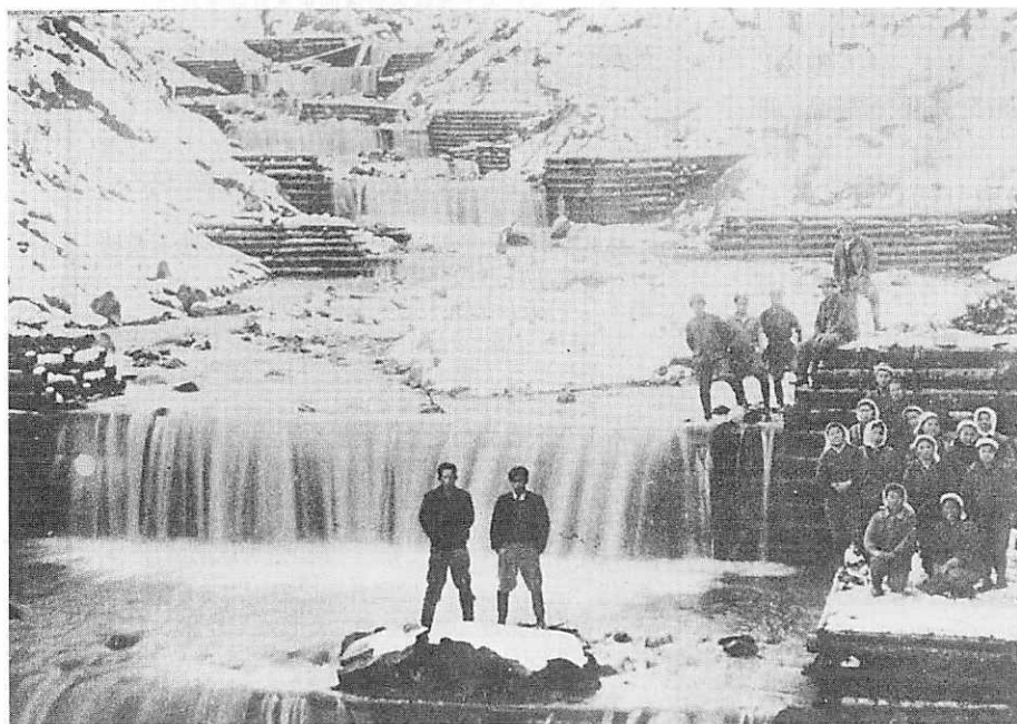
写真① 木枠堰堤工(昭和23年竣工、新潟県能生町柵口地内)
