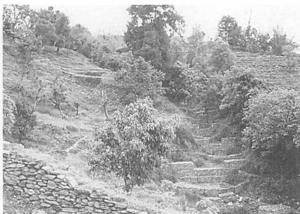
▲ 溪流保全工事（同左）・ワイヤー布団籠を枠にした空石積み堰堤の建設状況。手前は家畜進入防止用石積み柵であり、この内部で植林する
