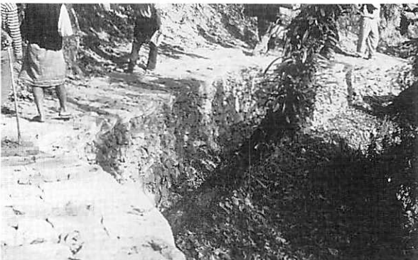
▲ 熟練工種の1つである歩道の石積み工
