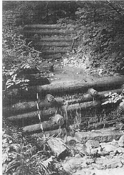
▲写真② スイス・チューリッヒ近郊山地 での木製谷止め工群
