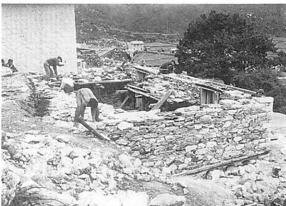
▲ 山間部での住居建設風景 （セメントは使わず石積みによる施工である）
