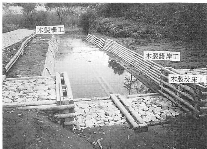
写真② 木製資材施工モデル現地
