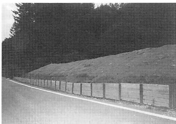
写真④ 残土処理場土留工
