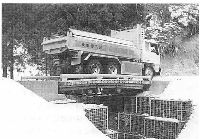
写真④ カンキョウ橋を走行する総重量23トンのダンプカー
