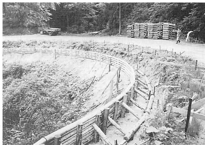
写真① 林道での木製柵工による盛土保護（ワンタッチウッディ柵工）
