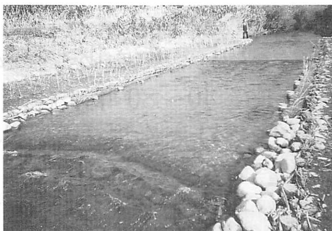
▲写真⑤ 木工沈床による産卵場の造成
