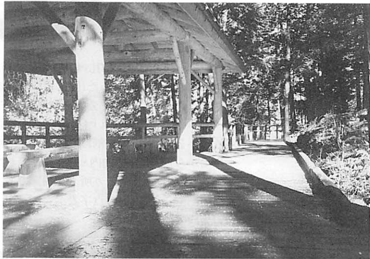
写真・遊歩道と一体となったデッキ構造 のあずまや（赤沢自然休養林）
