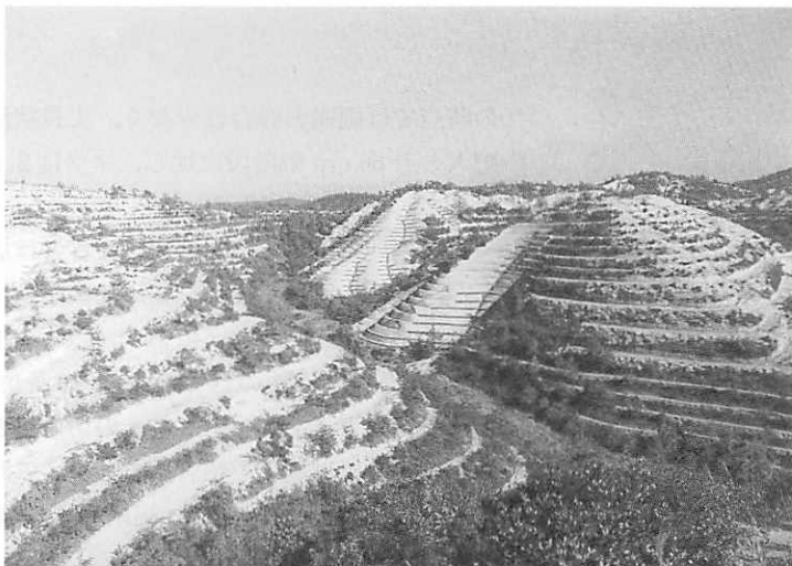
◀写真④ 広幅階段施工地 (階段切付完了時)・1968(昭 43)年
