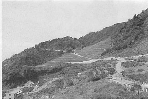
写真④ 排土工施工後の状況▲
