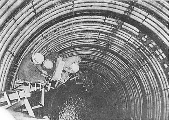
◀写真② 集水井工の 内部
